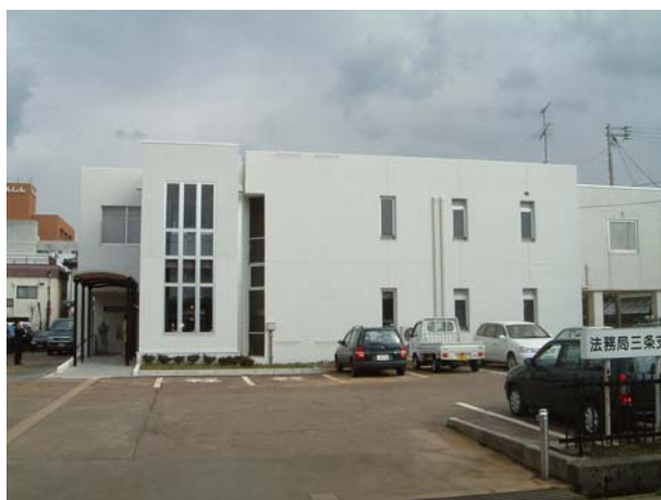
改修後 庁舎全景
