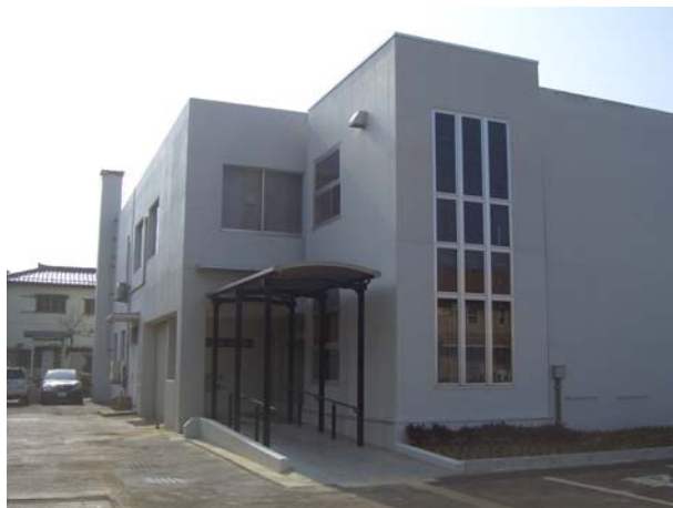
改修後 庁舎エレベーター増築部分
